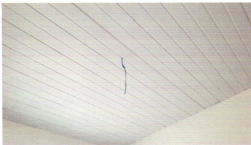
FOTO 01 – Forro de pvc, em régulas de 10 ou 20 cín, aplicado, inclusive estrutura para fixação (perfis em PVC) marca Araforros ou similar, instalado - Rev 06-10/2021
