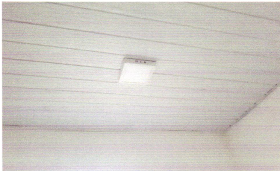
FOTO 03- LUMINÁRIA SOBREPOR QUADRADA LED 24W", 6500K G- LIGHT OU SIMILIAR
